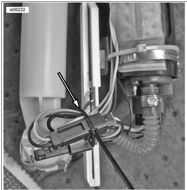
รูปภาพ 2 ยึดสายไฟและขั้วต่อปั้มน้ำมันเชื้อเพลิงให้แน่น
