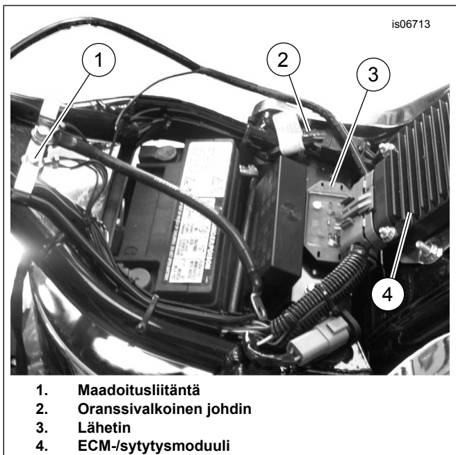
Kuva 7. Lähettimen asennus, Deuce
