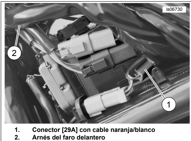
Figura 29. Ubicaciones del empalme de los cables (V-Rod de 2004)
