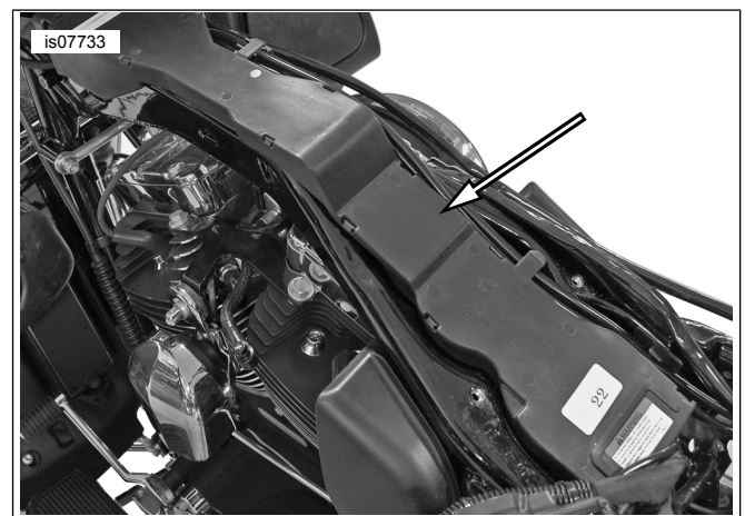
Figure 1. Conduit de fils
