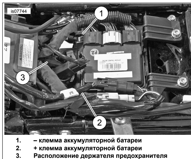
Рисунок 11. Подключение аккумуляторной батареи
